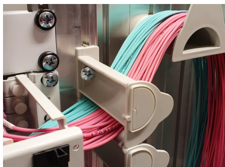
Bøybegrenser kan sikres ekstra med skruer/mutter
